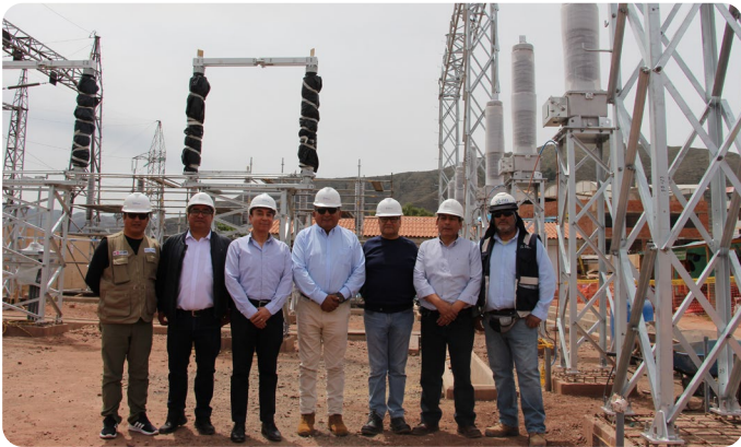
Electro Sur Este, en coordinación con el Ministerio de Energía y Minas, realizó una visita técnica a la obra “Ampliación de la Subestación Quencoro 138 kV – Celda de Transformación Plan Maestro 138/34.4/10.5 kV”, ubicada en el distrito de San Jerónimo.
