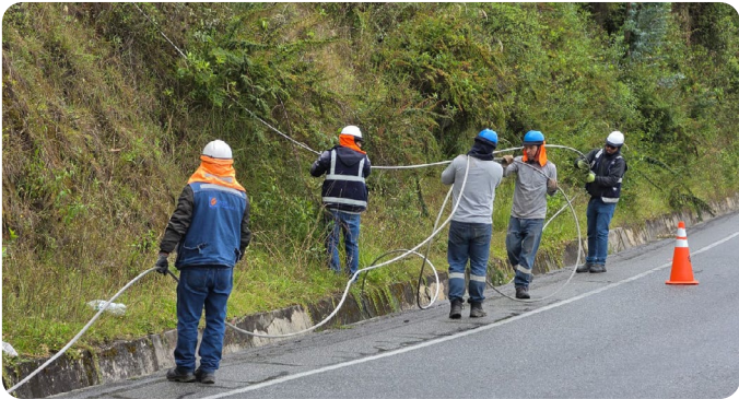
Restablecimiento de energía Apurímac.
