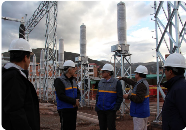
Visita técnica a la obra de ampliación de la Subestación Quencoro.
