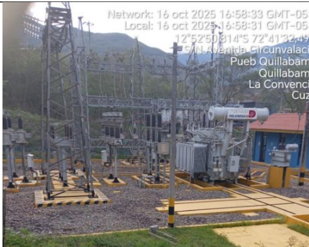
Columnas a desmontar
