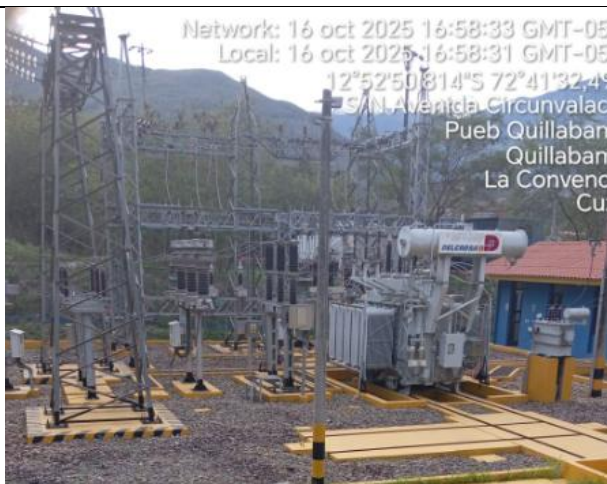
Columnas de pórtico.
