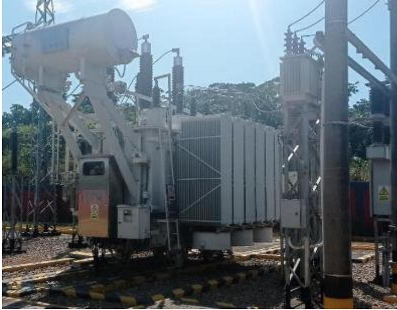
Imagen N° 1. Poza de contención del transformador de potencia
