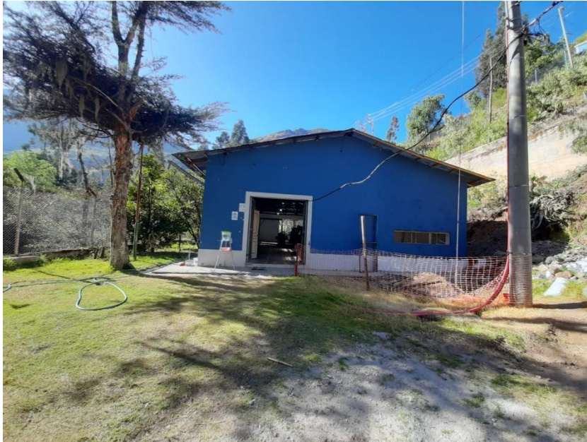
Figura N°6 : Casa de Maquina C.H. Vilcabamba
