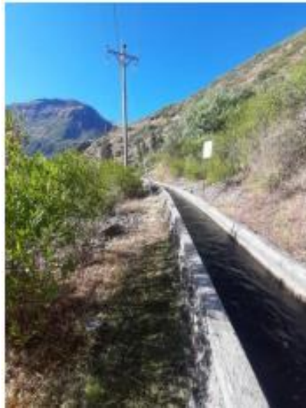
Figura N°8 : Canal de Conducción C.H. Vilcabamba
